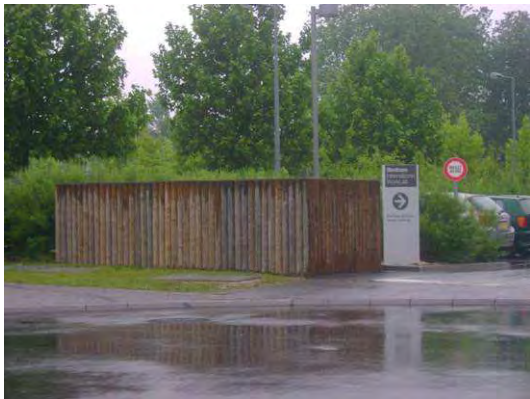
Containers de tri des déchets intégrés et accessibles pour faciliter leur enlèvement.
