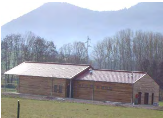
Bardage bois horizontal et toiture à deux pans.
