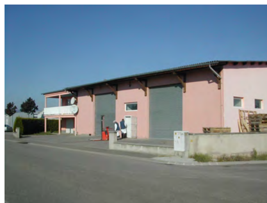
Absence totale de signalétique : illisibilité de l'entreprise.
