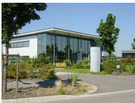
Le traitement paysager de la parcelle apporte une valeur ajoutée à l'image de l'entreprise.
