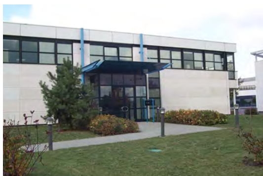
Les zones internes sont hiérarchisées, en fonction de leur usage, les flux piétons et routiers sont distincts.
