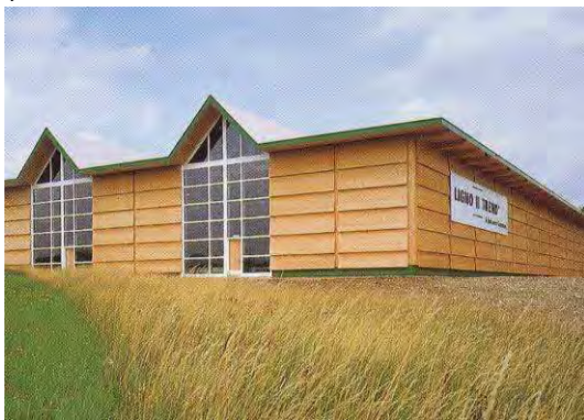
De larges percements qui simplifient le plan de façade et donne une meilleure compréhension du bâtiment.
