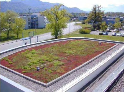
Toiture végétalisée permettant une bonne rétention des eaux.
