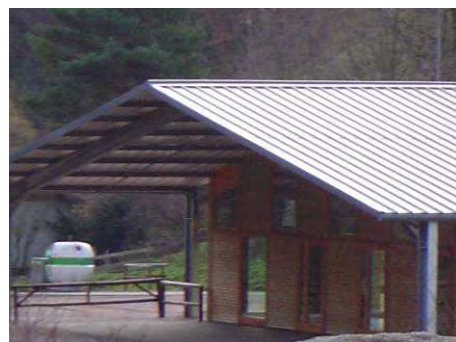
Toiture à double pans
