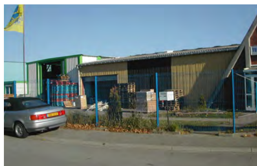
Absence de gestion du stationnement sur la parcelle Pas de distinction des flux piétons et routiers Zone de stockage sur l'avant
