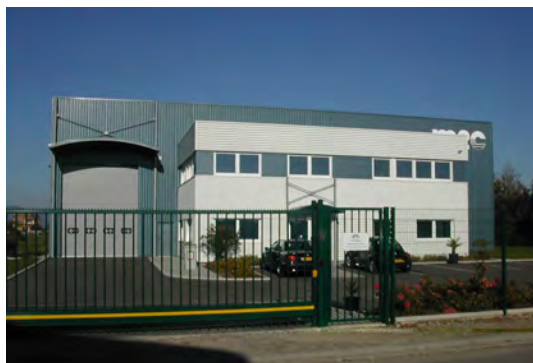
Accès visiteurs distinct de la zone de production
