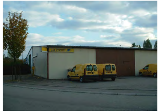
Aire de stationnement ouverte sur l'espace public. Pas de traitement des délimitations, ni des aires de stationnement.
