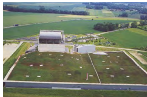
Végétalisation des toitures. Les toitures végétales permettent une rétention des eaux pluviales et de diminuer l'impact visuel des bâtiments dans le paysage.
