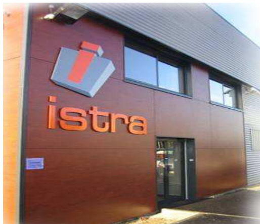
Lisibilité de l'entreprise pour le visiteur.
