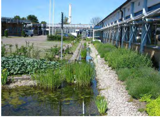
Plantation des soubassements et des façades avant.
