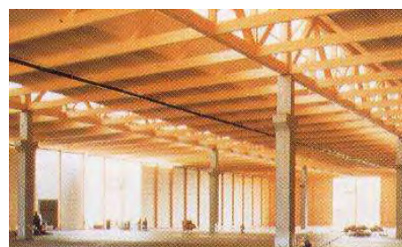
Une structure en bois permet de franchir de grandes portées
