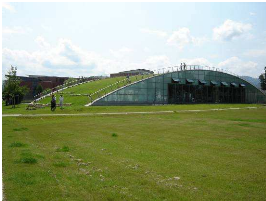
Une couverture totalement intégrée à l'architecture du bâtiment
