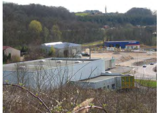
L'absence de traitement de la toiture, lorsqu'elle est vue, nuit à l'image d'une zone.
