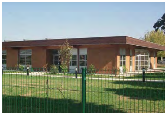
Un exemple réussi de bâtiment en bardage bois.
