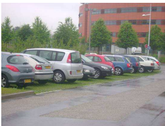
Dalles engazonnées utilisées pour la construction d'un parking.
