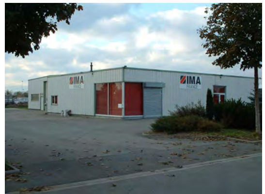
Plusieurs entrées figurent sur ce bâtiment monobloc, sans que l'on puisse distinguer à qui elles sont réservées (public, employés...).
