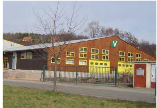
La multiplication de petits percements nuit à la lisibilité de la façade.
