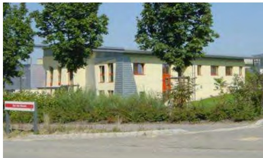
Bâtiment industriel en bardage métal : Le choix des couleurs, sobres, différencie bien les fonctions.
