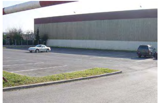
Un parking non engazonnés favorise le ruissellement des eaux pluviales....
