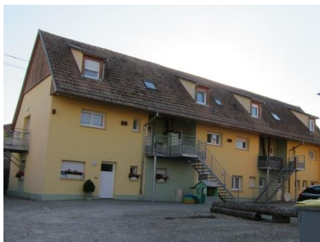
Photo : Un corps de ferme réhabilité en collectif à Artolsheim (Crédit photo : Eohs)
